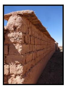
Côté maçonnerie l'artisanat local fait preuve d'un savoir faire évident notamment sur la manière d'édifier des murs ceinturant les habitations, L'assemblage de briques, conçues à partir de terre séchée en partie assure et permet comme nous pouvons le constater en repassant au même endroit de notre parcours, une construction rapide et régulière. Le muret que nous observions le matin à peine entamé est presque achevé en fin de journée
